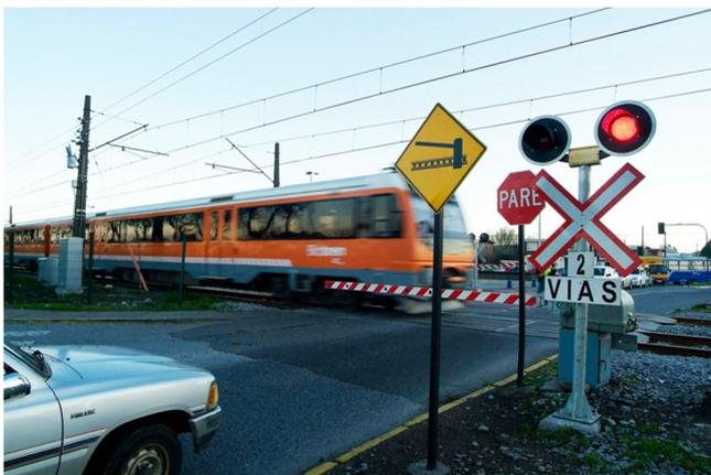
El paso a nivel E-300 es “Fail-Safe” SIL-4 según normas CENELEC, permitiendo diferentes configuraciones y soluciones tanto cableadas como vía radio.
